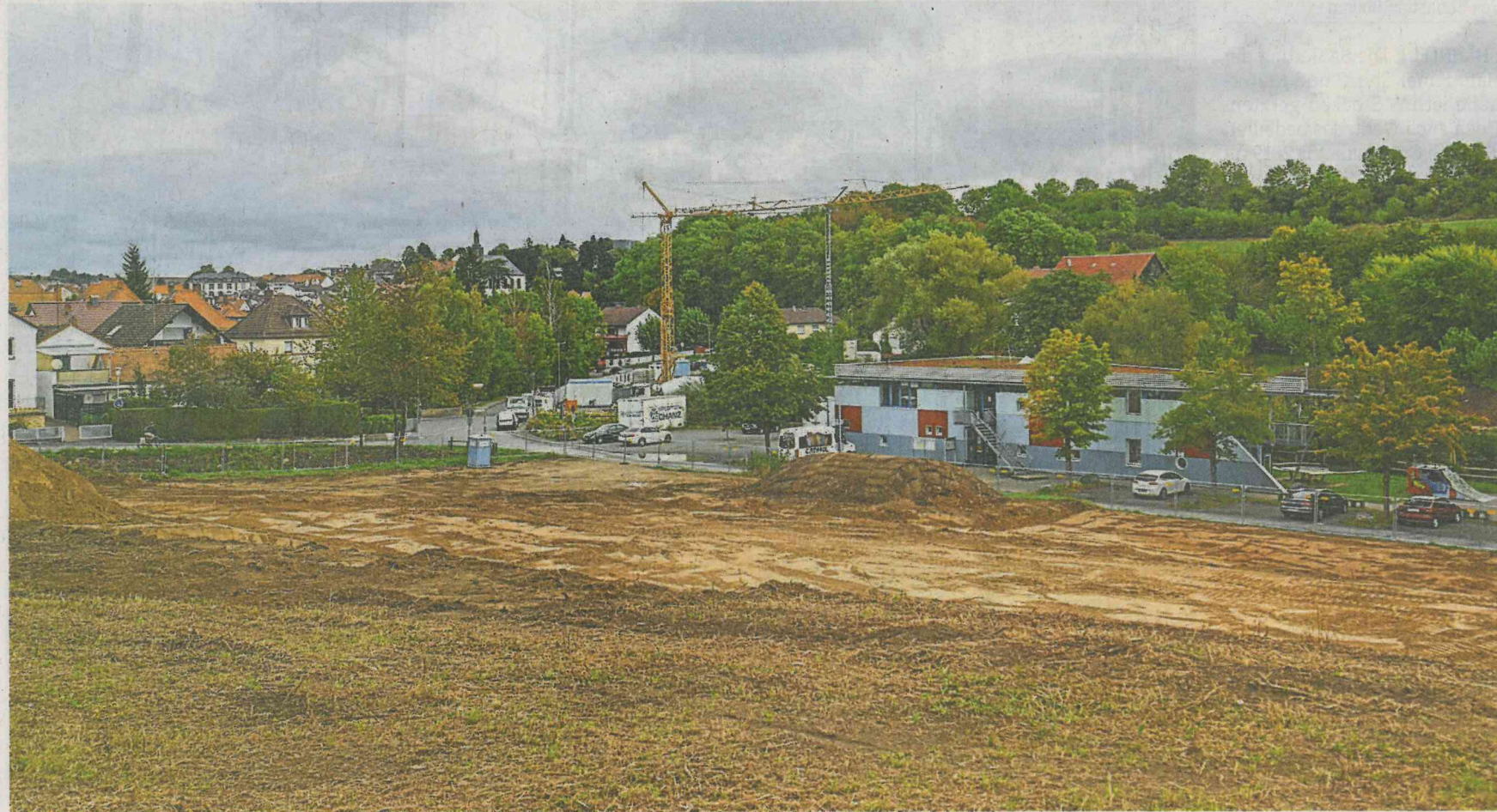
Die Erdarbeiten für den Neubau der Polizeistation in Ober-Ramstadt am Nieder-Modauer Weg gegenüber des Jugendzentrums Trio haben begonnen. Foto: Guido Schiek
