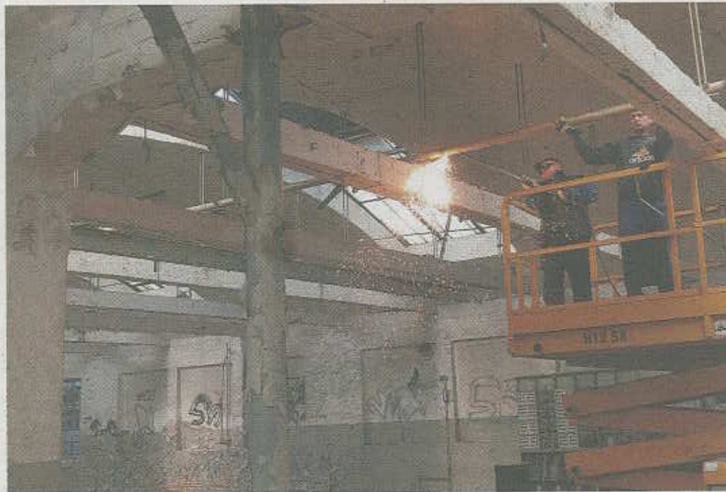
Die alten Hallen auf dem Miag-Gelände in Ober-Ramstadt werden entkernt und abgerissen. FOTO: KARL-HEINZ BÄRTL
